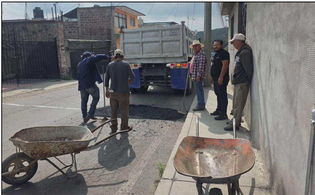
Donación de 3 toneladas de asfalto preparado para la construcción de 2 topes en la colonia El Cerrito, atendiendo una solicitud ciudadana.
